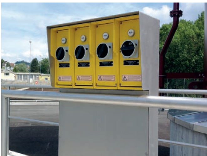
Vor-Ort-Schalter in Gehäuse 2812 gelb, ARA Herisau
