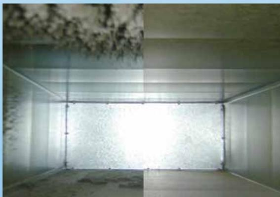
In den Lüftungsrohren und Kanälen kann sich im Laufe der Jahre sehr viel Staub, Schmutz, Fett und Öl ablagern. Eine fachgerechte Reinigung sorgt für eine saubere und reibungslos arbeitende Lüftungsanlage.
