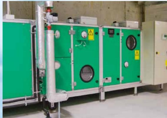
Das Lüftungsgerät (Monobloc) mit seinen Komponenten soll regelmässig gereinigt werden. Dabei werden die Register mit Hochdruck gereinigt und erreichen wieder ihre volle Leistung.
